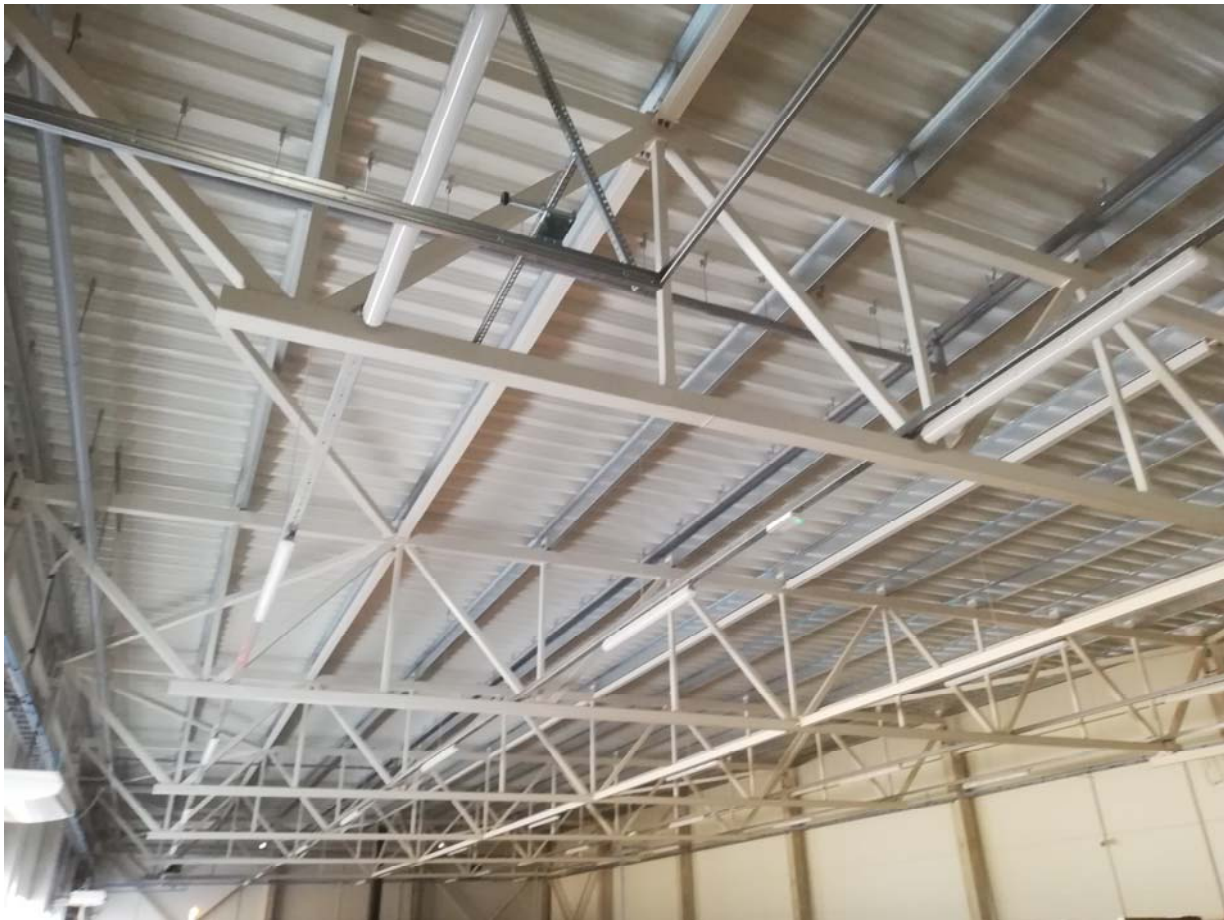
03 pav. Nagrinėjamo statinio stogo konstrukcijų fotografacija
