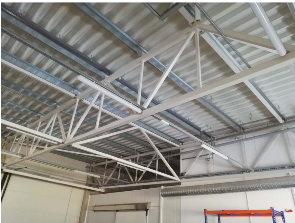
04 pav. Nagrinėjamo statinio stogo konstrukcijų fotografacija
